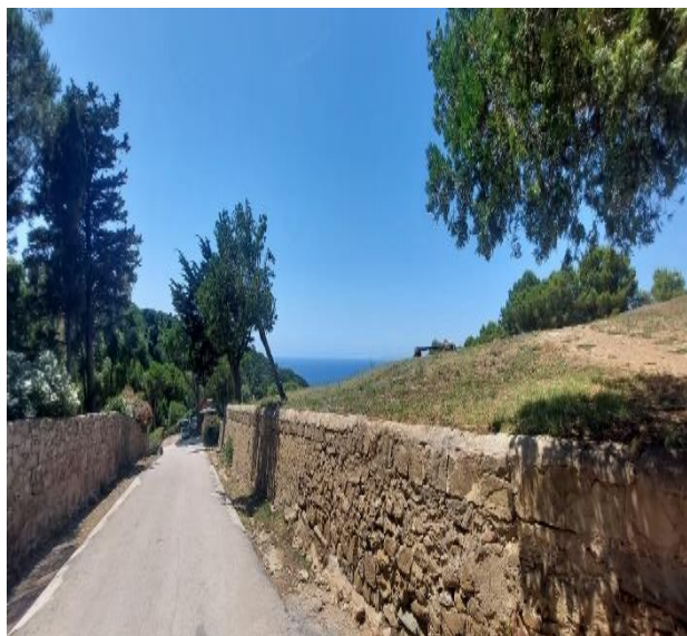
5 Rampa di ingresso in asfalto, dal parcheggio.
