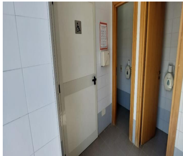
54 porta interna servizio igienico
