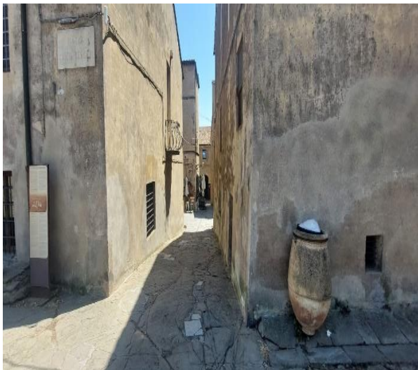
17 rampa sconnessa verso la Chiesa e Rocca
