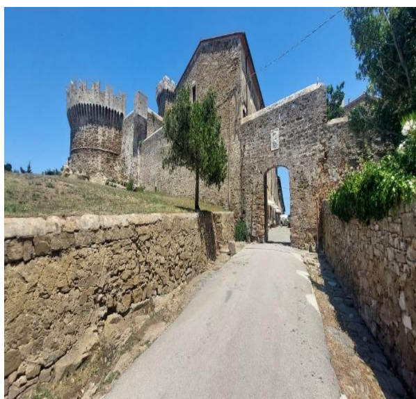
7 tratto finale rampa
